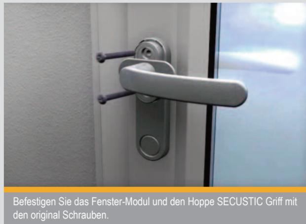
Befestigen Sie das Fenster-Modul und den Hoppe SECUSTIC Griff mit den original Schrauben.
