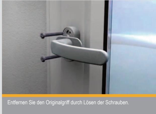
Entfernen Sie den Originalgriff durch Lösen der Schrauben.
